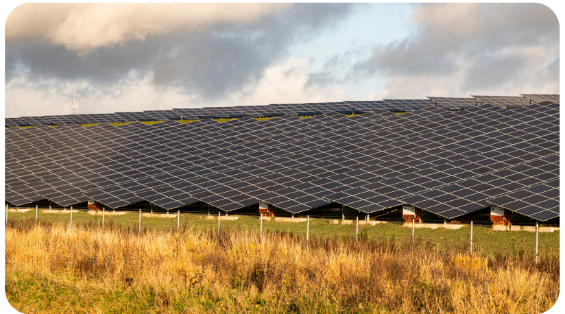
帕拉卡图光伏电站 - MG
